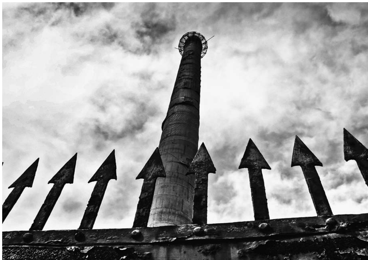
Ex stabilimento Italcementi, Senigallia. Foto di Francesco Buontempi; sotto : foto di 'O Sarracino.
