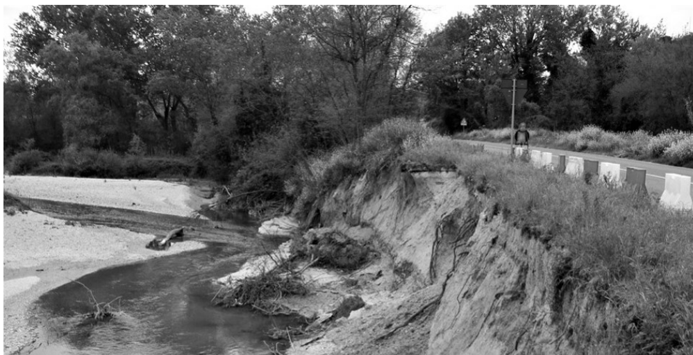
↓ Fig. 14 - Fiume Nevola, risultati dei lavori di protezione della sponda (Tesi Dr.ssa Cinzia Mosci, 2017).
