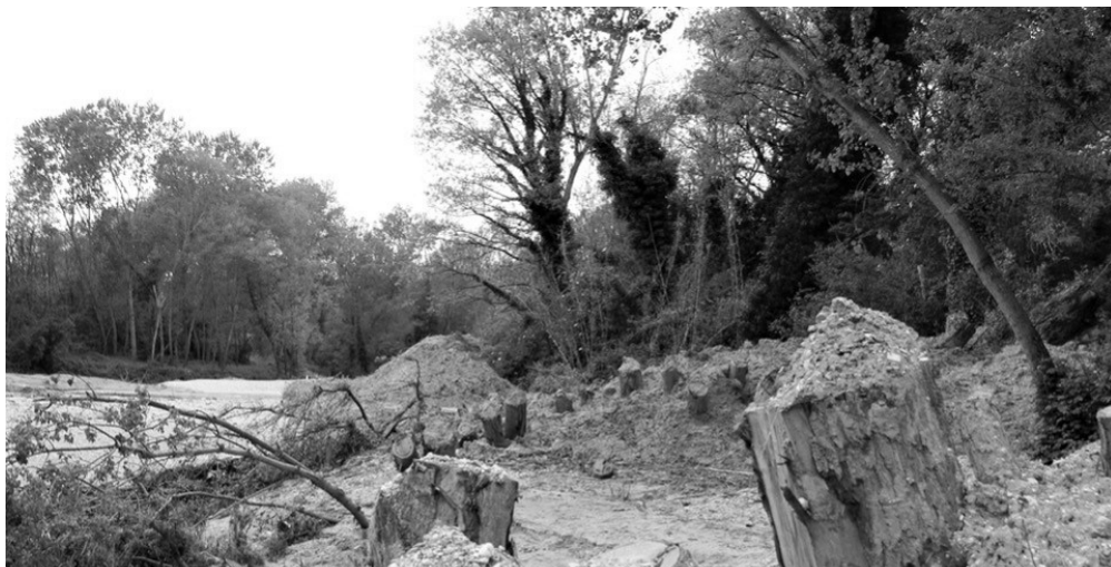
↑ Fig. 13 - Fiume Nevola, lavori di protezione della sponda con tronchi ricavati dal taglio del bosco presente nei pressi (Tesi Dr.ssa Cinzia Mosci, 2017).
