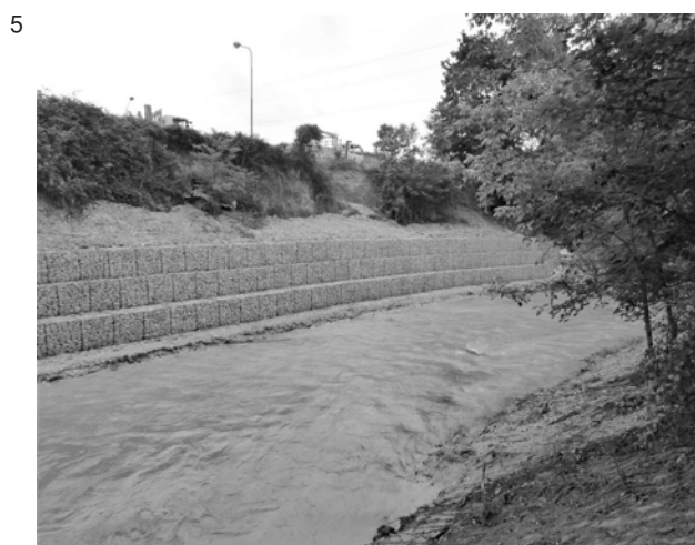
Figg. 3, 4, 5 - Fiume Tronto (2020), Fiume Esino (2014), Fiume Potenza (2021): tratti rimaneggiati e rettificati.
